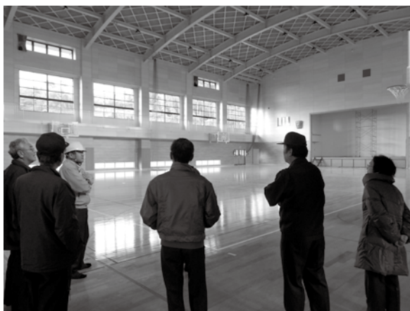
多良中学校屋内運動場・武道場建設の 進捗状況を視察
