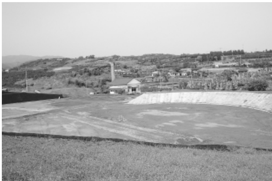
新火葬場造成地
