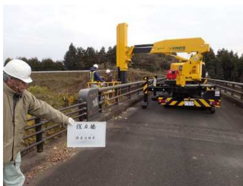
橋梁点検車による定期点検
