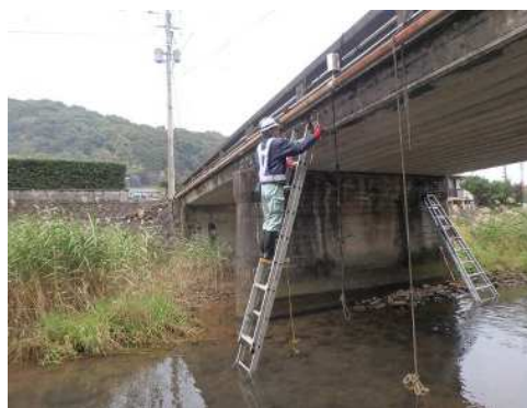
定期点検（打音検査）状況
