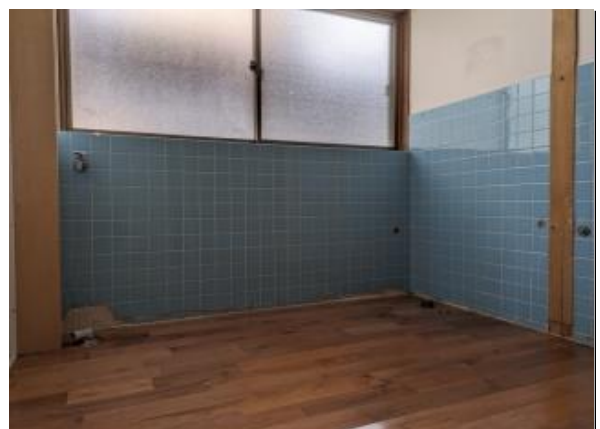
洗面・脱衣所（洗面台未設置）
