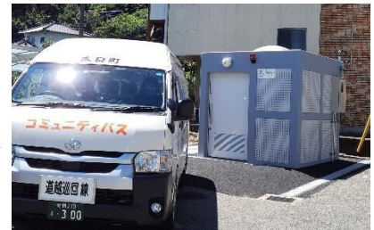
肥前大浦駅前の多目的水洗トイレ
