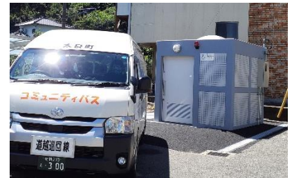
肥前大浦駅前の多目的水洗トイレ
