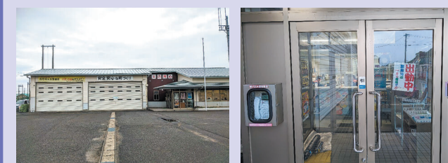
シャッター閉鎖中
