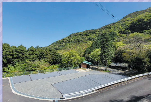
中山キャンプ場オートサイト整備工事
