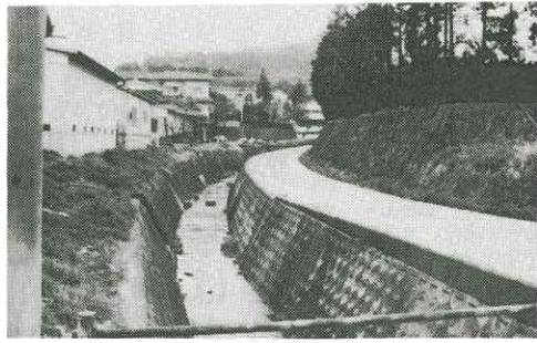
・拡幅が望まれる亀ノ浦神社線
