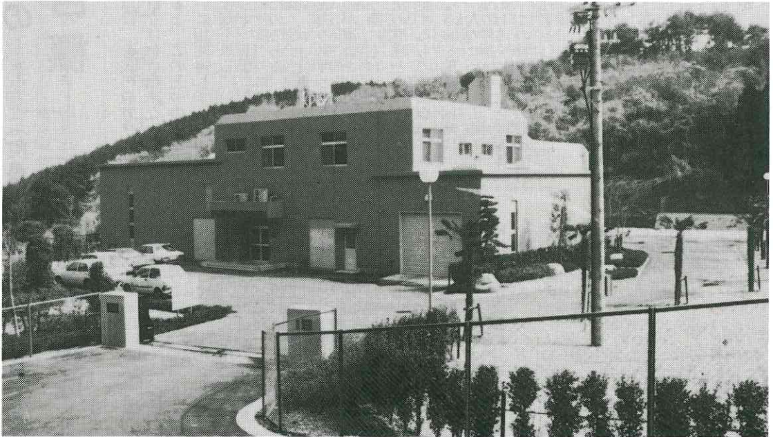
3.5億円で完成した、し尿処理場 (風配の当木地区)
