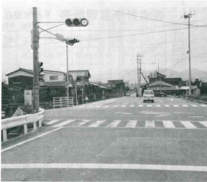
国道444号線から太良への整備が重要……
