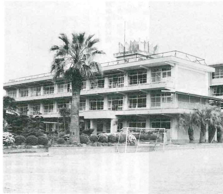
アスベスト（天井の壁）対策工事実施の多良中学校
