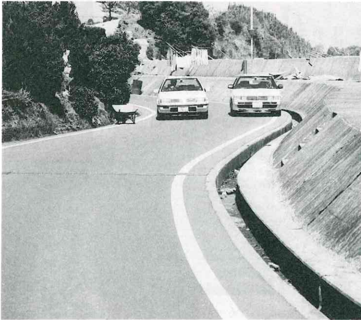
歩道の設置を要望される野崎海岸道路
