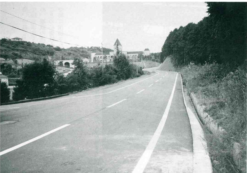
さざんか高原の拡幅舗装された町道
