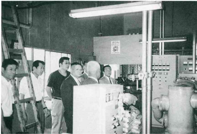
製氷・冷蔵施設の管理室
