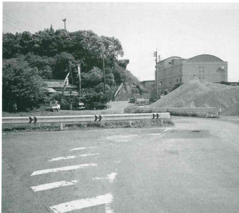
改修が望まれる大浦港湾道路
