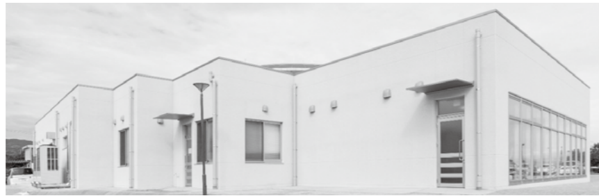
町立太良病院リハビリテーション室等増築工事
