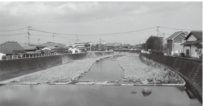
▲しゅん濇後の多良川
