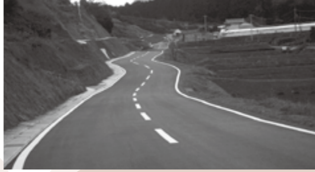
辺地対策事業町道端月線舗装工事(端月)
