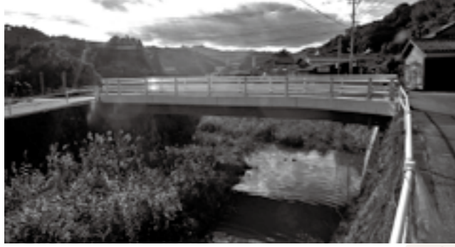
社会資本整備総合交付金事業綾部橋補修工事(伊福)
