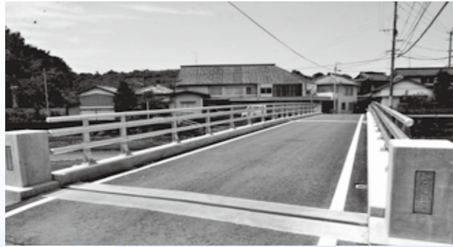
橋梁維持補修事業(糸岐橋)
