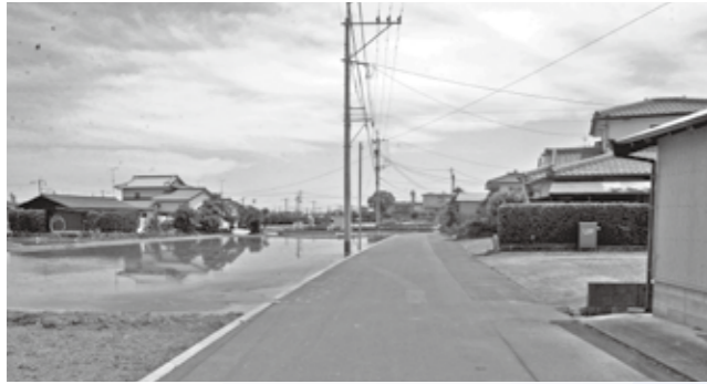
町道新設改良事業(尾辺田線舗装工事)
