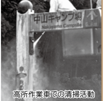
高所作業車での清掃活動
