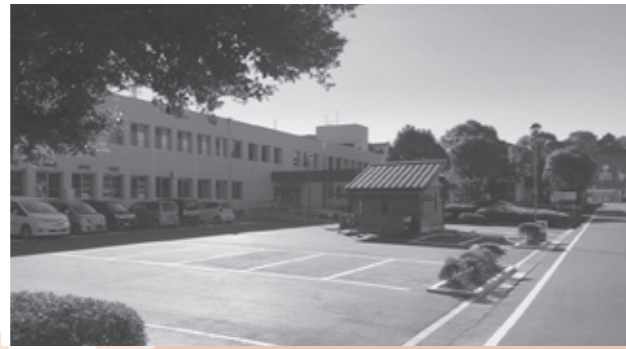
自然休養村管理センター外構整備事業
