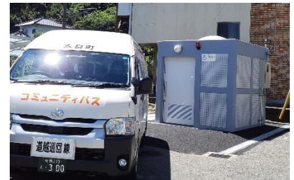
肥前大浦駅前の多目的水洗トイレ
