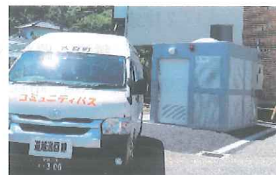
肥前大浦駅前の多目的水洗トイレ
