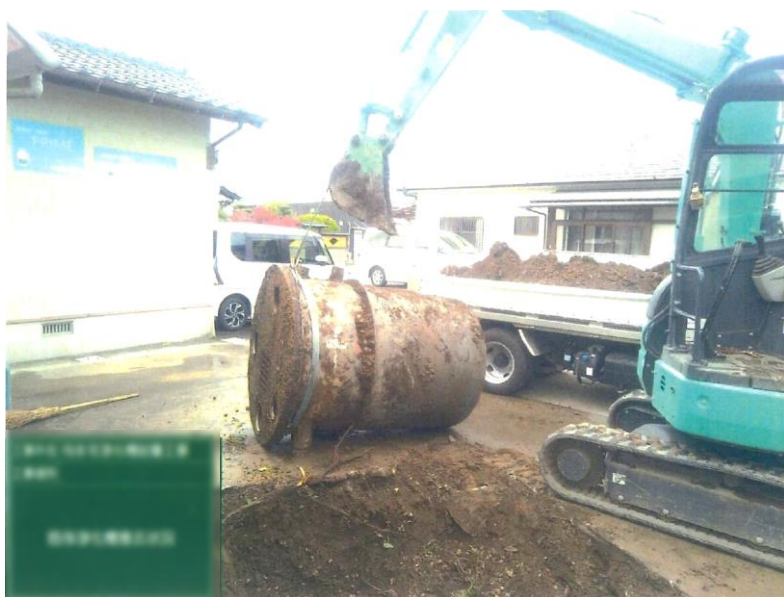
単独浄化槽又はくみ取り便槽 撤去物写真
