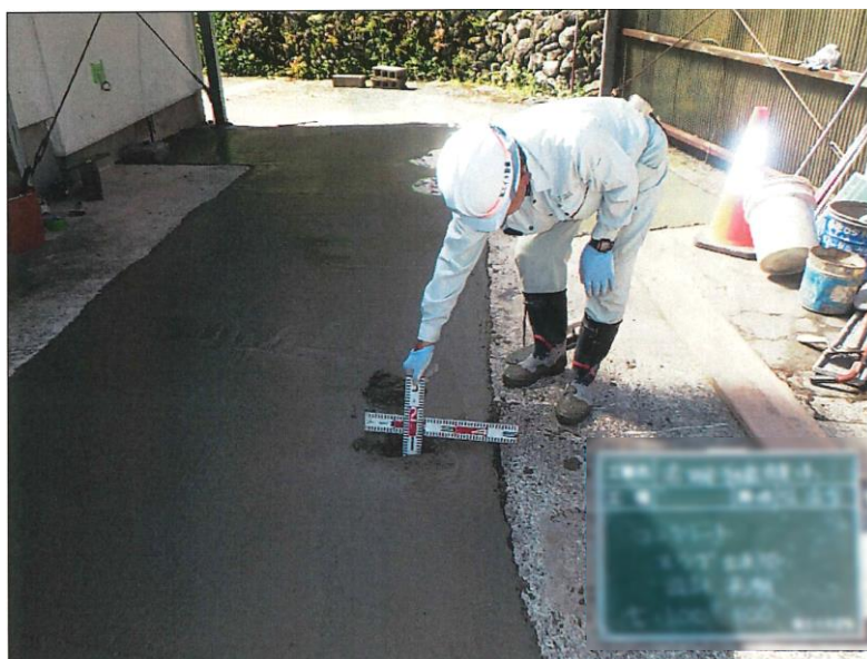
埋め戻し状況（コンクリート）
