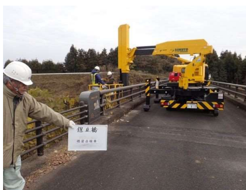
橋梁点検車による定期点検
