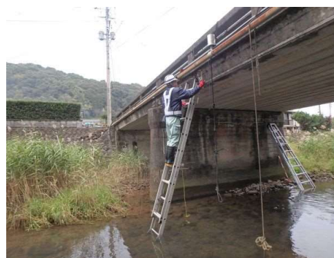
定期点検（打音検査）状況
